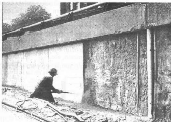
Renovación de un muro de hormigón armado.
